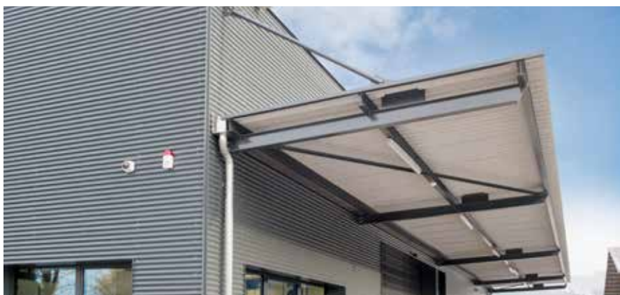
Werkstattfassade mit Vordach
