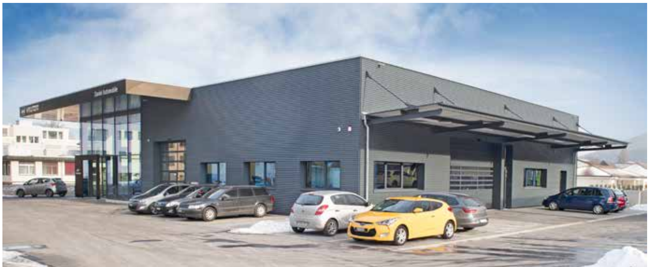
Werkstatt Rückseite mit Vordach
