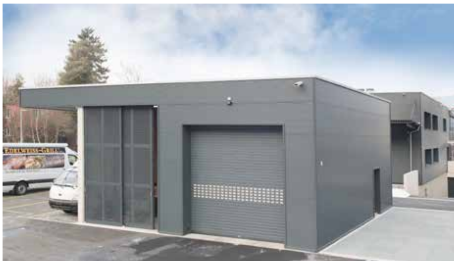
Waschanlage mit Rolltore
